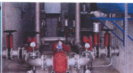
Le biogaz est transformé en électricité et en chaleur dans une centrale de cogénération. L'électricité ainsi produite alimente le réseau électrique et la chaleur sert au chauffage des bâtiments.
